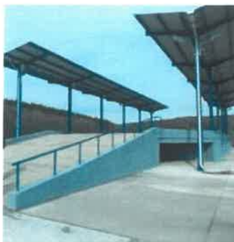
Figură 4-1 Stație de transfer
